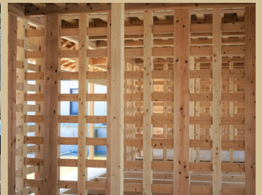
東京大学大学院木質材料科学研究室の学生による「平間柱貫工法」でつくられた壁面る大型構造体の制作風景(2021年10月)
