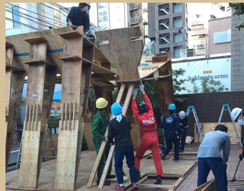
東京大学大学院木質材料科学研究室の学生による「平間柱貫工法」でつくられた壁面る大型構造体の制作風景(2021年10月)
