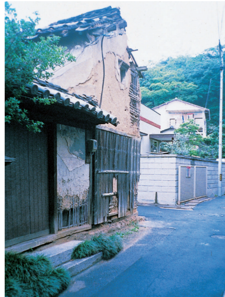
修復前の「角屋」 “Kadoya” before renovation.
